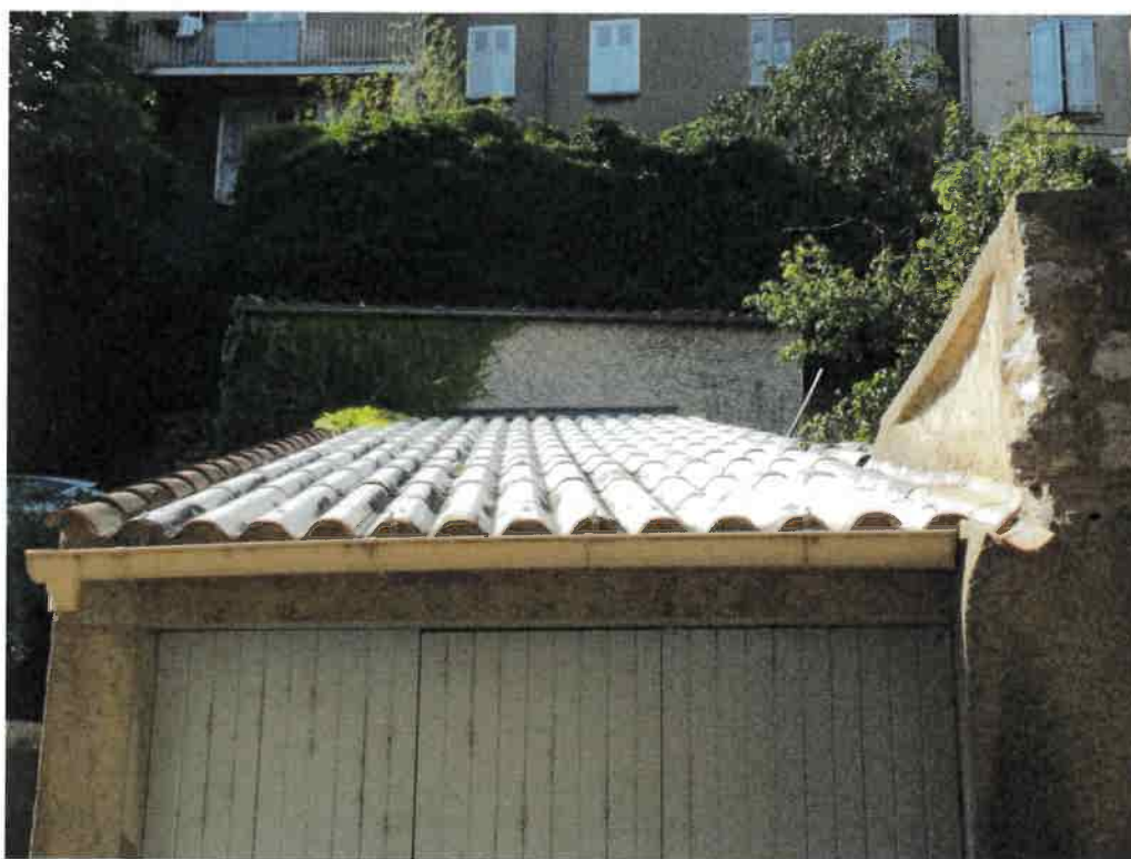
Toiture garage (suspicion PST plaques sous tuiles en fibro amiante)
